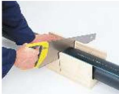
1. Отрезать трубу перпендикулярно оси, используя специальный труборез, циркулярную пилу или ножовку. В последнем случае, для получения прямого сечения рекомендуется использовать направляющее устройство.
